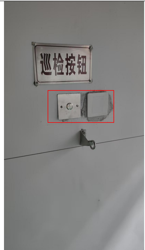
辐照室内巡检拉线开关
