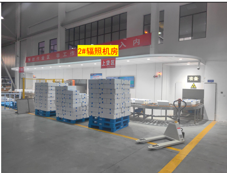
2#辐照机房整体外观
