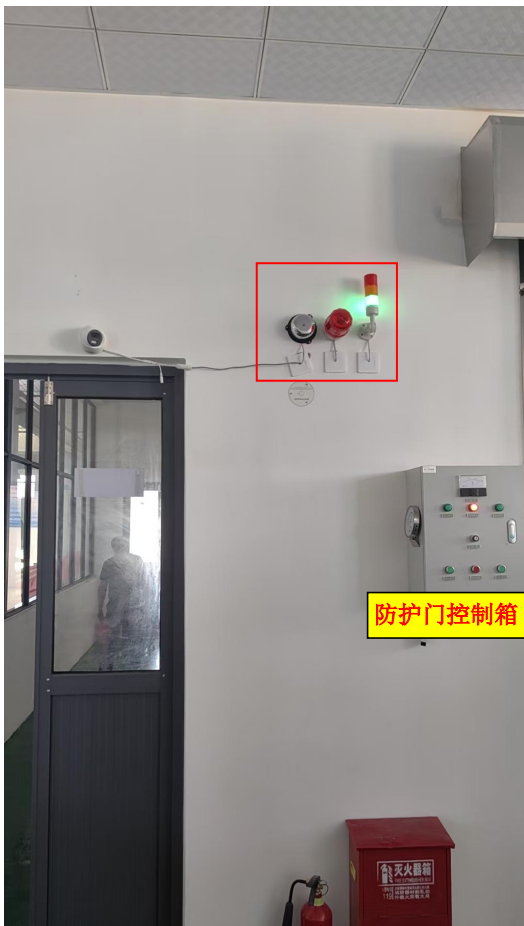
主机室防护门外警灯、警铃、三色灯
