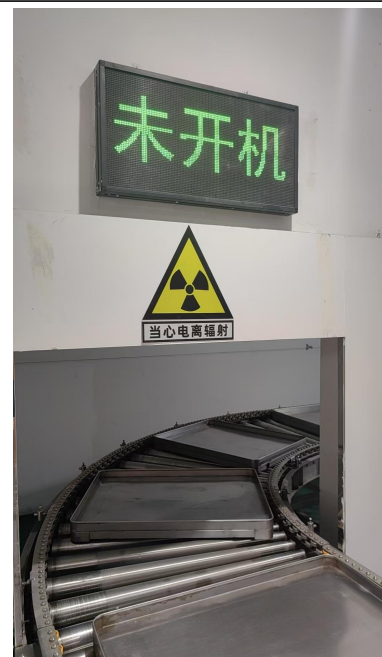
辐照室出口处电离辐射标志
