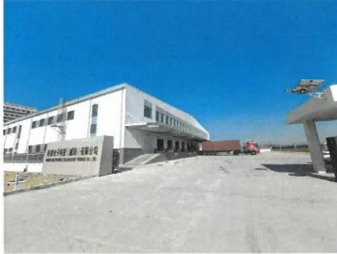
项目现场照片
